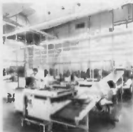
Bild 4: Siebdruckverfahren - mit der Ätzstation verknüpft
