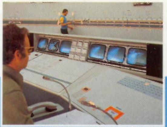
Fernsehkameras des bewährten Systems FA 70 haben sich unter härtesten Bedingungen im Einsatz für die Sicherheit im Dauerbetrieb bewährt. Bei der Fahrt durch den Arlberg – im längsten Straßentunnel der Welt – ist auch Ihre Sicherheit durch die Überwachung mit 47 Grundig-Fernsehkameras gewährleistet. Sie ermöglichen dem Kontrollpersonal rund um die Uhr den Sichtkontakt mit allen Bereichen des Tunnels,
