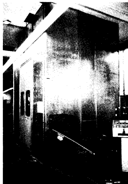
Bild 7 Materialauslauf an der Spezial-Kapselung
