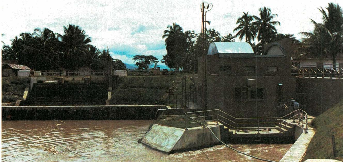
Fig. 19. – Microcentrale de Wonodadi (Indonésie), équipé d'un groupe bulbe de 262 kVA, vue aval (doc. CGEE-Alsthom).
