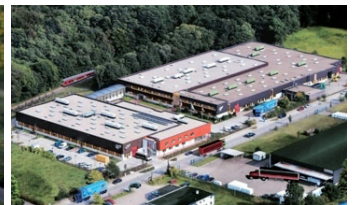
Technique de fabrication NORD Gadebusch
