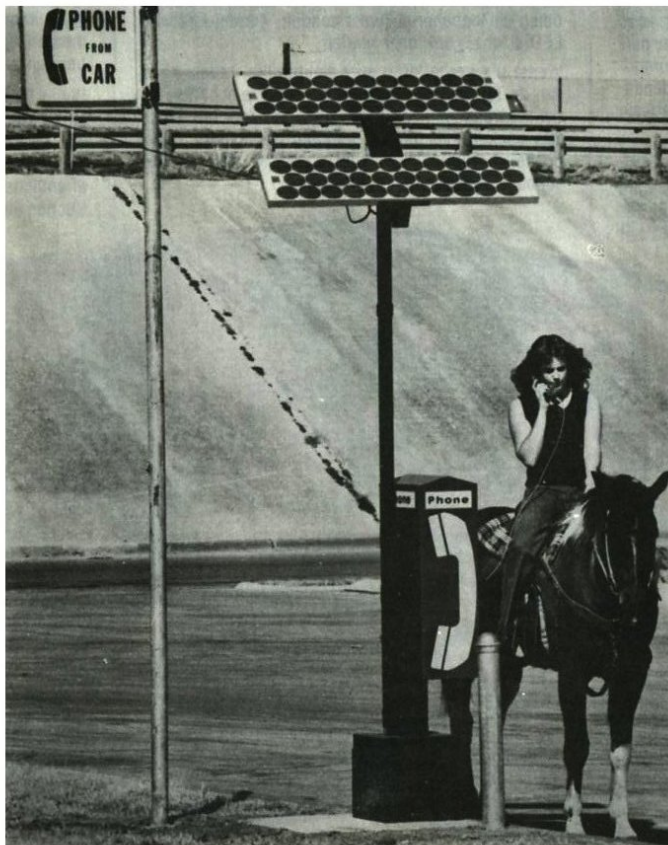
Deux panneaux solaires fournissent l'électricité nécessaire à l'éclairage de cette cabine téléphonique expérimentale de la Southwestern Bell à Bedford, dans le Texas.
