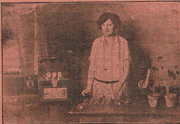
La Doctoresse Mac Manis, de Chicago, étudie l'influence des ondes électro-magnétiques sur la germination des végétaux. Pour ses expériences, elle emploie un oscillateur que l'on voit à gauche.
