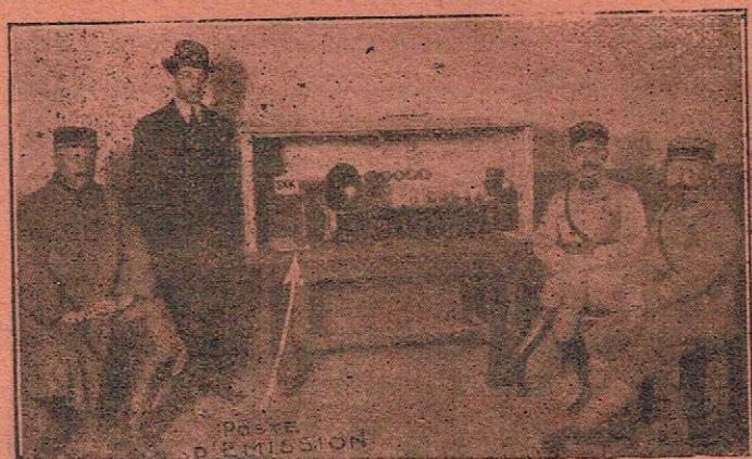
Le poste d'émission portatif « 8 K », installé par notre collaborateur Géo Kosak dans la caserne du 6 e Génie et qui entretenait, avec 20 watts alimentation, la liaison entre Angers, Tours et Avignon. De gauche à droite: Lieutenant Dulorier, Géo Kosak, Colonel Letourneur, Colonel Corbière.
