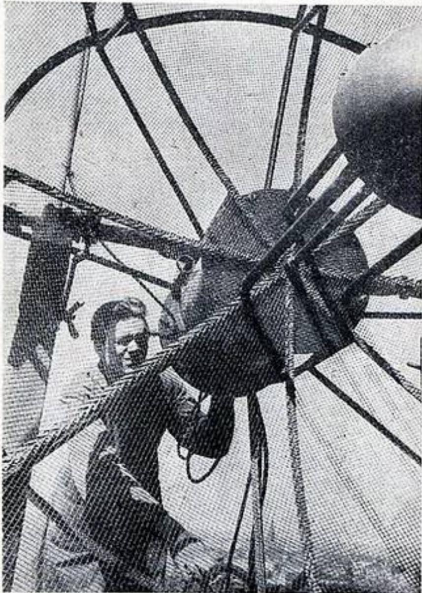
FIG. 3. — Réflecteur parabolique pour ondes de 15 cm installé à 8 m au-dessus du toit du studio de télévision de l'Exposition. (Photo Nowea, Düsseldorf)
