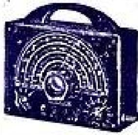
d'un grand cadran gradué en mètres et en Kilobertz. Trois gammes plus une gamme MF étalée : GO de 140 à 410 kHz - 750 à 2.000 mètres - PO de 500 à 1.800 kHz - 180 à 600 mètres - OC de 6 à 21 MHz - 15 à 50 mètres. Une gamme MF étalée graduée de 400 à 800 K. Présenté en coffret tôle galvanisée. - Dimensions : 200x145x60.
