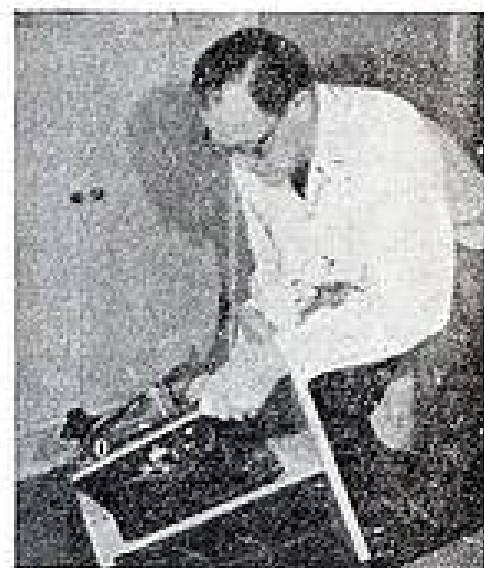
2. — La plupart des tourne-disques à trois vitesses sont fournis avec un gabarit donnant toutes les dimensions de perçage.
