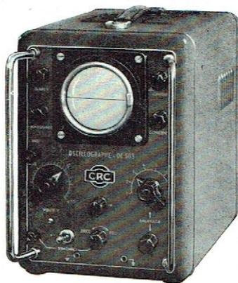
L'oscilloscope cathodique OC 503 présente, sous un faible volume, des caractéristiques spécialisées qui permettent de l'employer dans le domaine des impulsions (télévision, radar, comptage, etc...)
