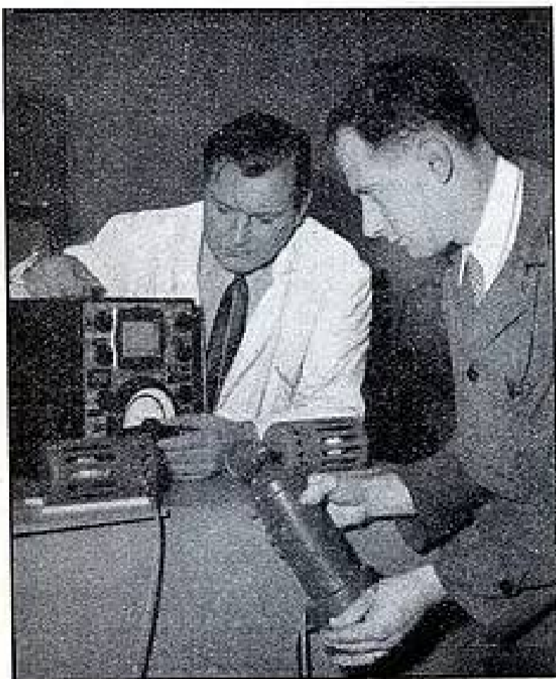
Ci-contre, M. R. Koenen et M. A. Lapeyre, des Laboratoires AUDAX, sont en train de mesurer à l'aide d'un analyseur Pimonow le son résultant produit par les deux faisceaux d'ultra-sons.
