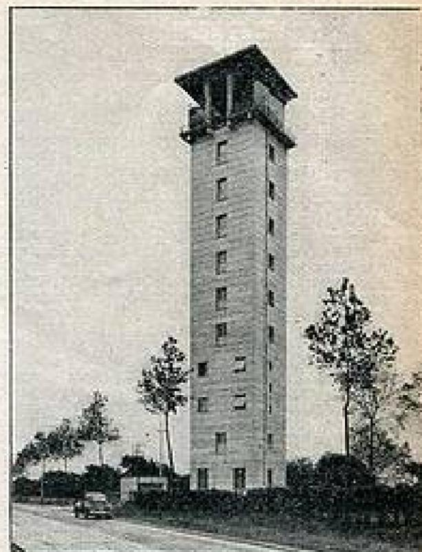
Une des tours relais ayant servi à la transmission. Sur la plate-forme du haut, on distingue les projecteurs servant à la réception (à gauche) et à l'émission (à droite) des faisceaux hertziens.
