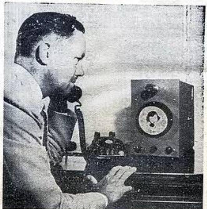
Voici le « Picturephone », téléphone-télévision réalisé aux Etats-Unis par la société Bell. L'appareil de droite comporte un écran rond sur lequel apparaît l'image de la personne appelée; on voit au-dessus, l'objectif destiné à transmettre celle du demandeur. En remplaçant les lampes par des transistors, les constructeurs se proposent de réduire encore le volume du récepteur et de l'incorporer à l'appareil téléphonique pour ne former qu'un seul instrument qui sera alors mis dans le commerce.
