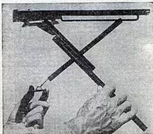
FIG. 5. — Chaque miroir est monté sur un pied individuel fait de 2 tiges métalliques à charnière.
