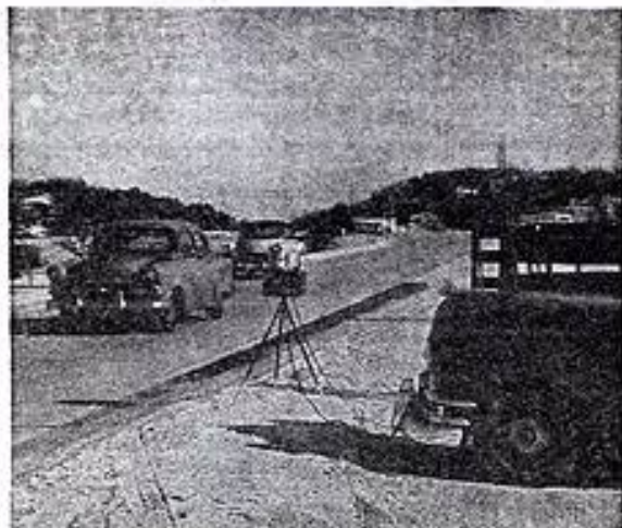
Fig. 1. — Installation d'un radar de contrôle sur trépied, à proximité d'une route américaine.
