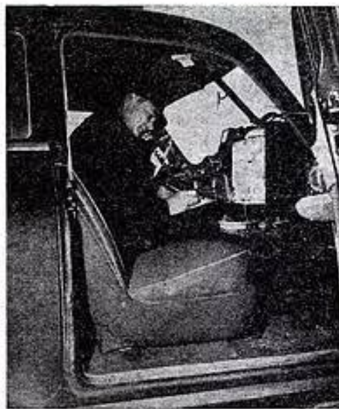
Fig. 2 — Lecture de la vitesse d'une voiture suspecte, par un policier de la route, à l'aide d'un cadran commandé par l'appareil de radar.
