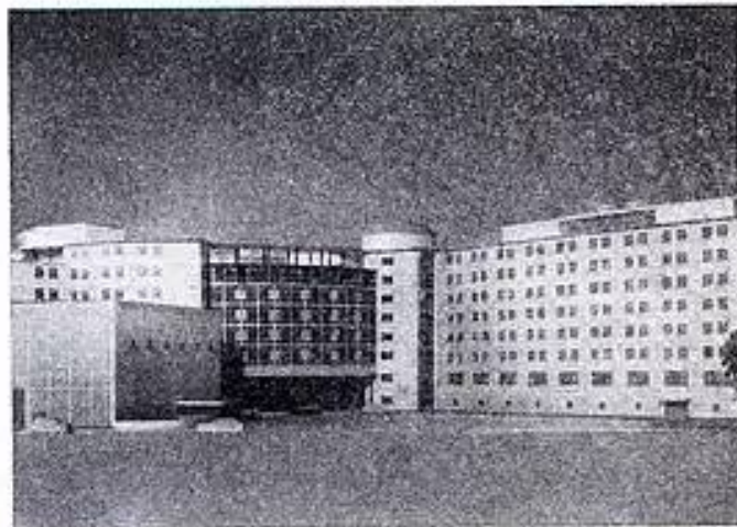
2. — Vue générale au sol, prise du nord, du bâtiment principal et de l'aile future.
