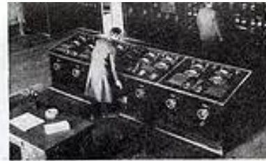
Antenne - studio à radio-télévision. Partie de construction et de montage.
