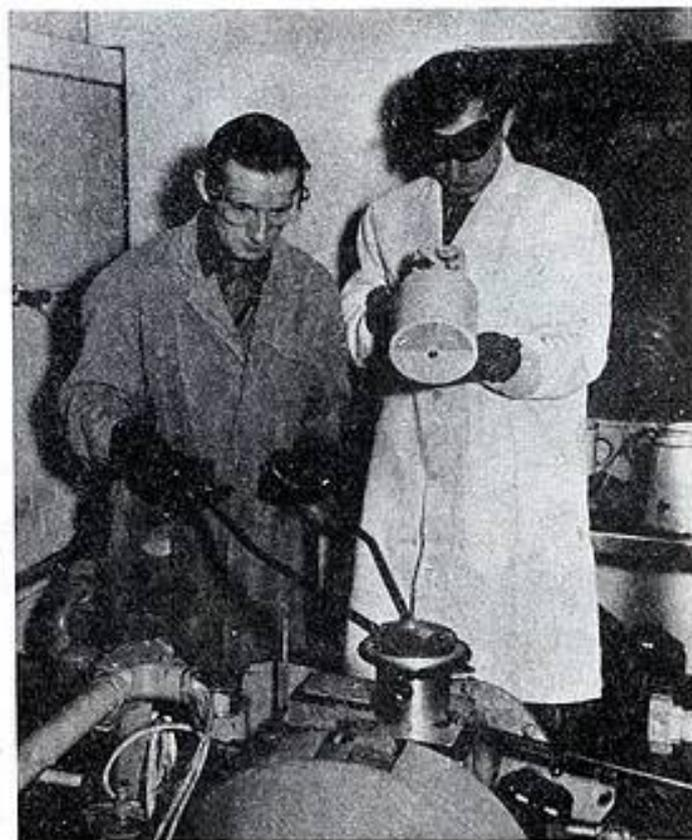
Fig. 1. — Un segment radio-actif est monté dans le cylindre. Le contrôle de radiation des particules de fer mêlées à l'huile de graissage, à l'aide d'un compteur de Geiger, permet de déterminer l'usure avec une précision extrême. De grandes précautions doivent être prises pour la protection des opérateurs. (photo Shell.)
