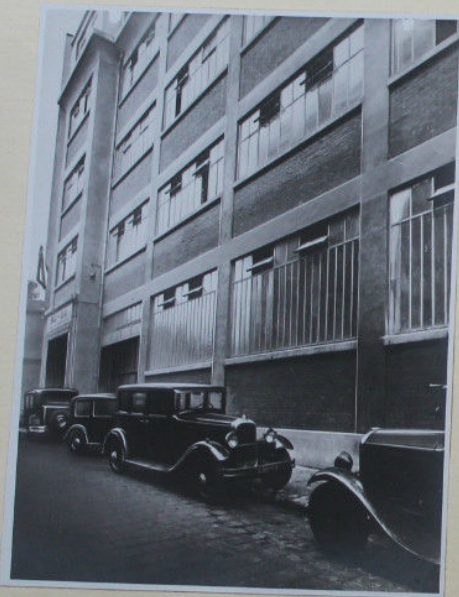
FACADE DE L'USINE, 17, RUE LIGNER, PARIS (XX e ).
