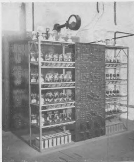
Vue d'une des herse pour essais de durée des lampes de T. S. F. Dans chaque lot de lampes, des témoins sont pris pour être soumis à des essais de durée dans les conditions d'utilisation normale.
