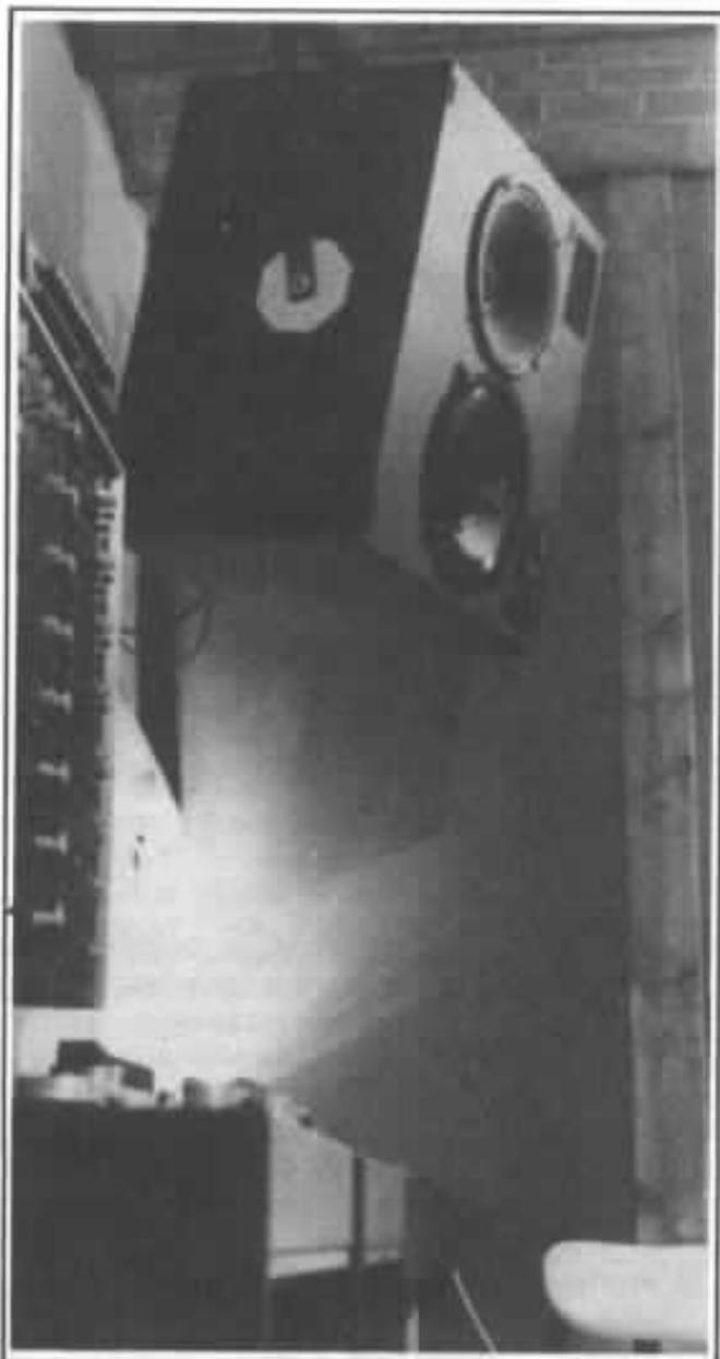
Fig. 12 : Les enceintes acoustiques sont suspendues à l'aide d'un système de fixation permettant toute forme d'orientation lors de la mise au point du studio.
