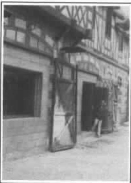
*Fig. 4 : Transformation des écuries. La fenêtre et les portes acoustiques d'accès à la salle d'enregistrement sont déjà en place. Remarquer que les anciennes portes en bois permettant de dissimuler toutes les modifications apportées au bâtiment. L'étage supérieur est occupé par la grande salle d'écoute, le bar, le lieu de détente et par des salles techniques.*
