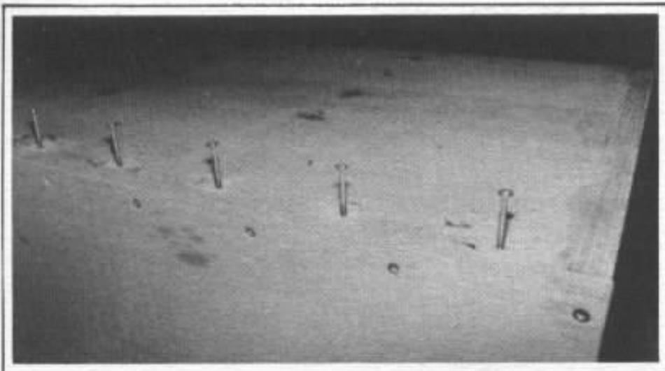
Photo 21 : Fixation du fond. Remarquer la position en quinconce et perpendiculaire des vis.
