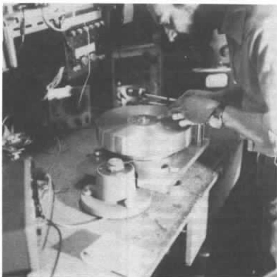
*Comptage des raies du stroboscope défilant pendant une minute en vue de la correction du diamètre des gorges de la poulie du moteur.*
