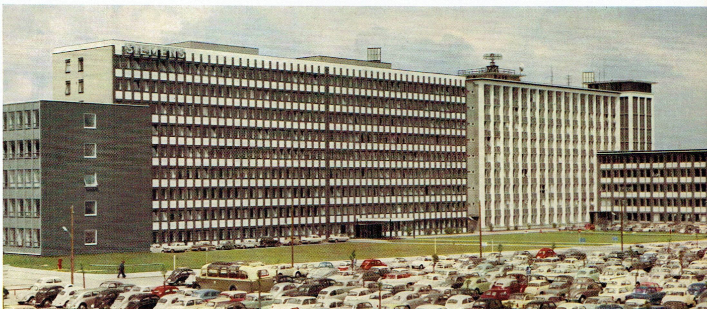
Fig. 1 Le bâtiment du «Centre de développement pour la technique des télécommunications» à Munich. Ce bâtiment abrite les laboratoires centraux et la majeure partie de l'effectif du département «Zentral-Konstruktion» qui compte plus de 1000 personnes. Il comprend de plus des salles d'enseignement pour la formation professionnelle du personnel et des jeunes cadres. Dans les salles d'exposition, des maquettes et des modèles d'appareils donnent aux visiteurs et aux membres du personnel un aperçu des développements réalisés dans le domaine des télécommunications
