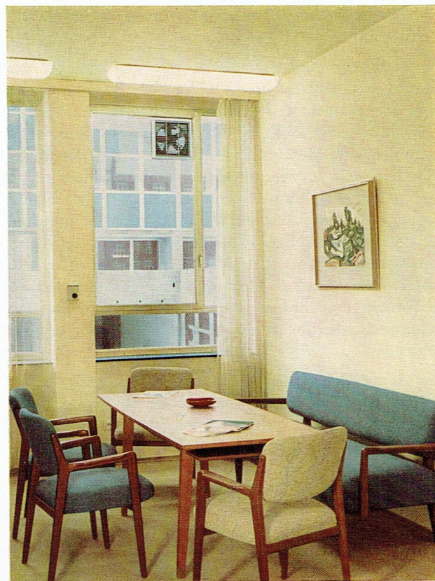
Fig. 1 Salle de conférence avec ventilateur monté dans la fenêtre. On reconnaît entre les deux fenêtres le commutateur permettant d'obtenir différentes vitesses et de faire fonctionner le ventilateur comme ventilateur aspirant ou comme ventilateur refoulant
