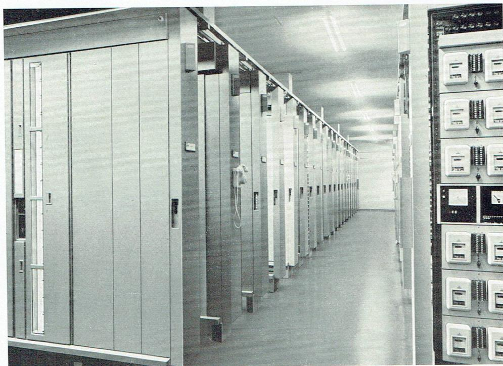
Fig. 2 Salle des sélecteurs du central de Dortmund-Osten, le 1000<sup>ème</sup> central urbain EMD Siemens. A droite un bâti avec des erlangmètres pour le service de mesure du trafic
