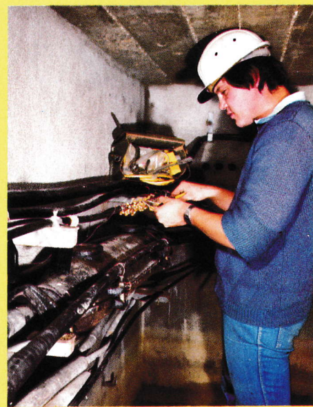
2. Epissures dans une chambre de raccordements (SIC PTT).
