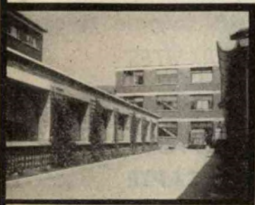
★ Vue des bâtiments D et J
