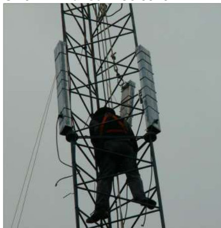
Installation des antennes. Été 2012.
