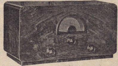
mit 2 Niederfrequenzstufen und eingebautem Sperrkreis. Eingerichtet für Schallplatten-Uebertragung.
