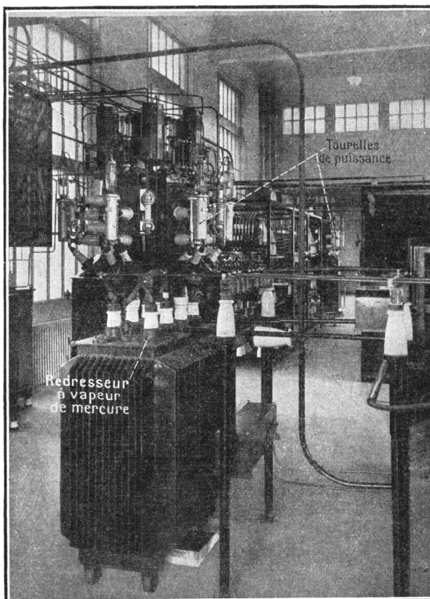
FIG. 5. — VUE DE LA SALLE D'ÉMISSION, MONTRANT, DE L'AVANT À L'ARRIÈRE, LES REDRESSEURS À VAPEUR DE MERCURE, UNE PREMIÈRE TOURELLE DE PUISSANCE, LES CIRCUITS OSCILLANTS ET, TOUT AU FOND, LA DEUXIÈME TOURELLE DE L'ÉTAGE DE PUISSANCE
