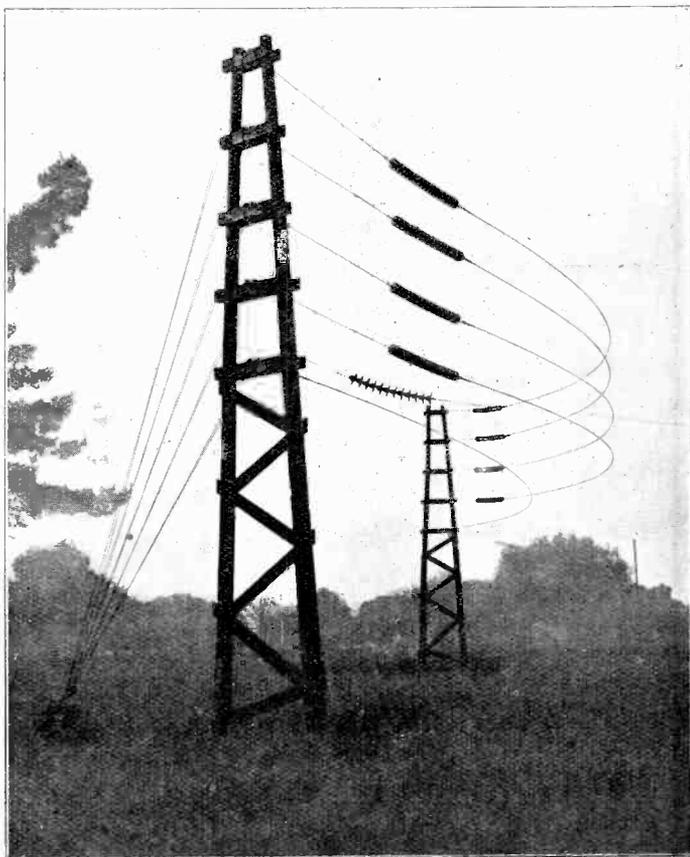
END SUPPORTS OF THE DUMMY ANTENNA.
