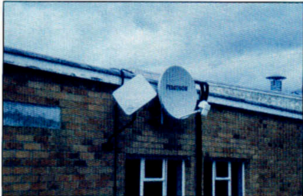
Deux antennes, une parabolique, une plane, chacune orientée vers son satellite ASTRA et B.S.B.
