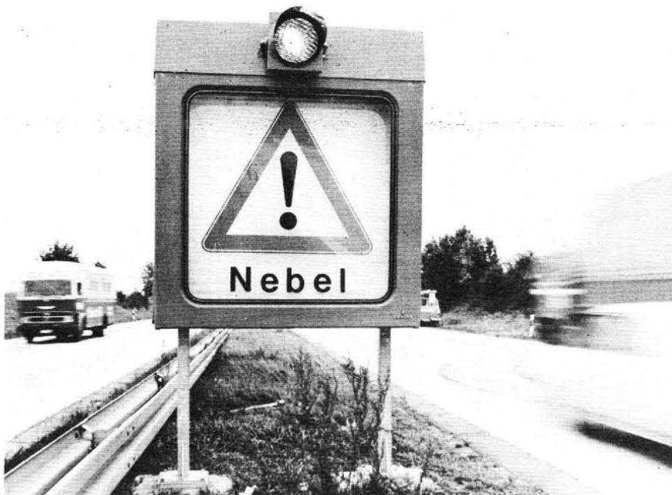
Fig. 10. — Aspect du panneau de signalisation automatique de brouillard (Siemens).
