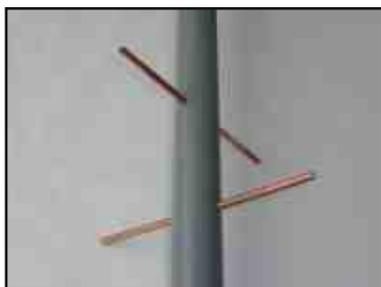
Placez au sommet du mât le boîtier décrit ci-dessus. Percez le mât à 100cm en dessous de l'axe des 4 trous du boîtier puis un deuxième trou à 90° de ce dernier, mais à 90cm de l'axe des 4 trous du boîtier (figure de gauche).
