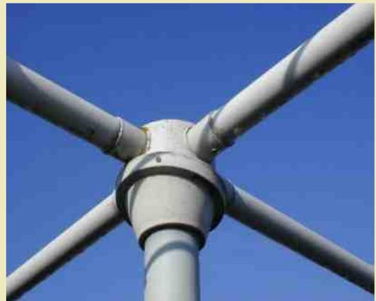
Laissez 1 ou 2 bon centimètres de tube au deçà du perçage pour la mise en place d'un bouchon de fermeture.
