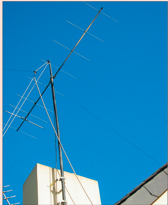
3 - Solution plus "légère", l'antenne fixée en pignon ou sur la cheminée (F5MPW).
