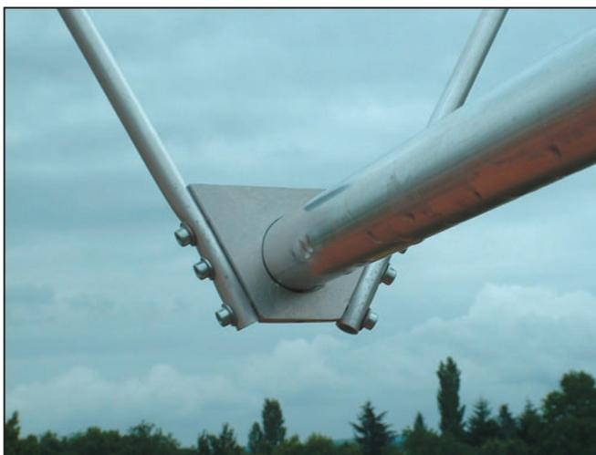
4 - La fixation d'un triangle sur le support à l'aide de 6 vis BTR.
