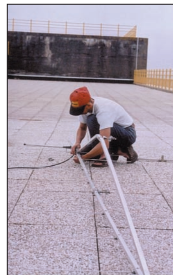
3 - Assemblage de la 17 éléments par Vincent F4CTV.
