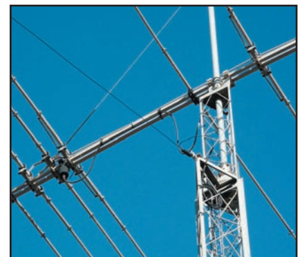
La fixation au sommet du pylône.
