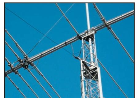
Figure 4: La fixation au sommet du pylône.
