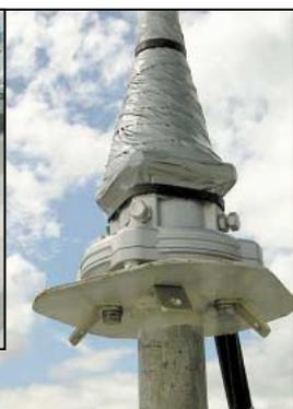
La platine soutenant le roulement. Notez l'étanchéité réalisée sur la partie supérieure du roulement.
