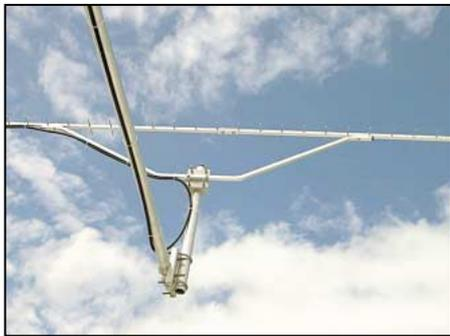
Sur un balancier horizontal sont montés deux bras de déport verticaux, pour les UHF et SHF.
