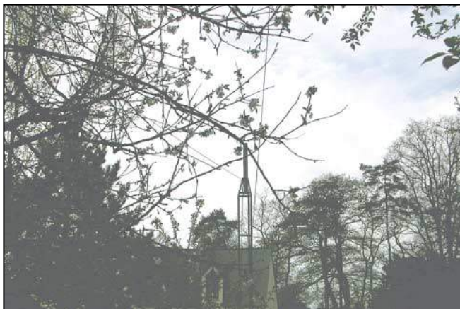
Le fil d'antenne traverse les arbres : ce n'est peut-être pas une bonne solution !
