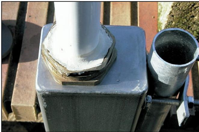
Un joint d'étanchéité recouvre le presse-étoupe du boîtier.
