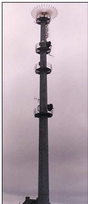
Les antennes du CROSS Jobourg.
