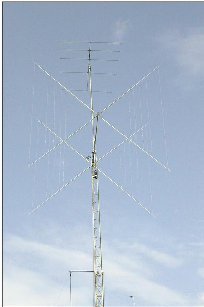
L'antenne montée. En haut, une 5 éléments 50 MHz.
