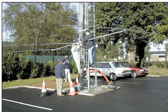
Montage d'une 3 éléments 18 MHz.
