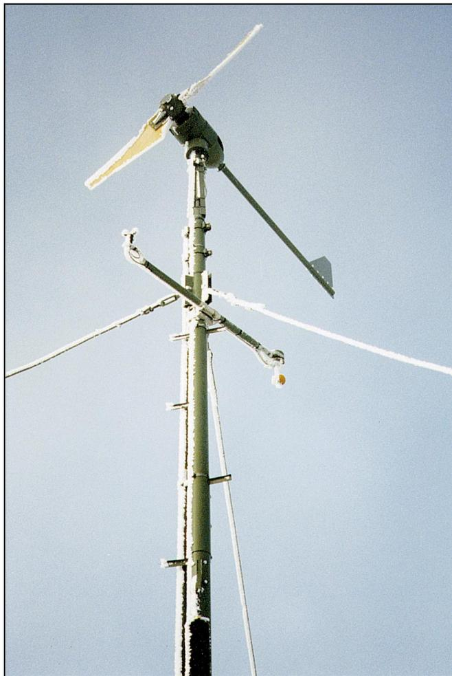
Eolienne du relais HB9G à 1600 m d'altitude. Janvier 1997, température de -20°, l'éolienne est givrée. © Serge NAUDIN, F5SN
