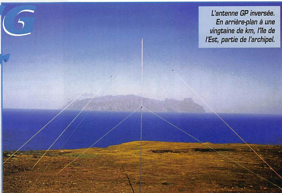
L'antenne GP inversée. En arrière-plan à une vingtaine de km, l'île de l'Est, partie de l'archipel.
