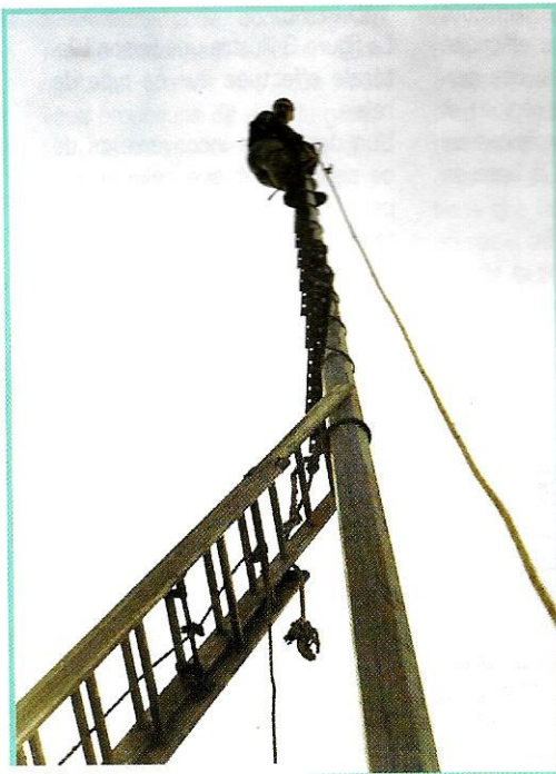
Grimper. Installer les antennes.
