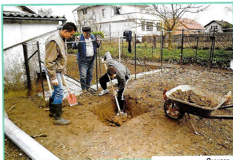
Creuser. Fondations du pylône.
