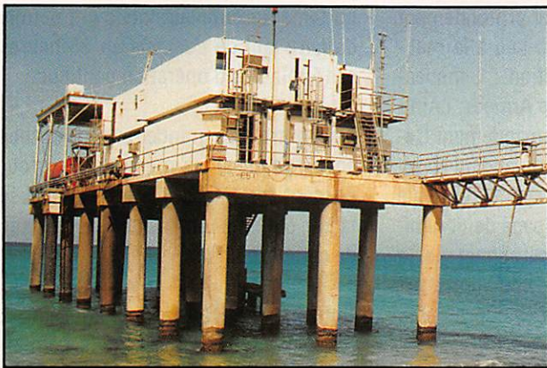
La station "Simon Bolivar" montée sur pilotis.
